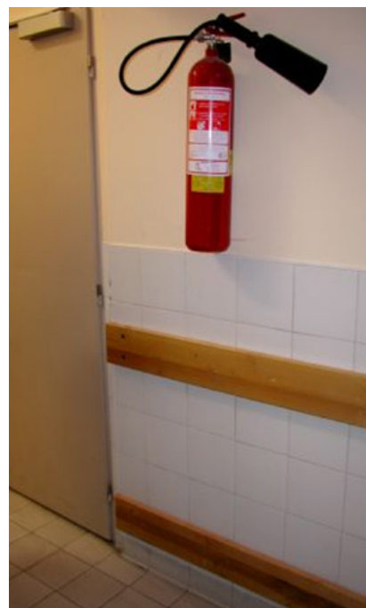
Neúmerne vysoko zavesený prenosný hasiaci prístroj
