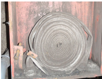
Nesprávne zvinutá a poškodená hadica
