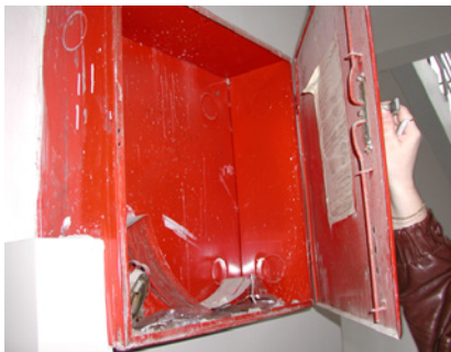
Chýbajúce vybavenie hydrantovej skrine
